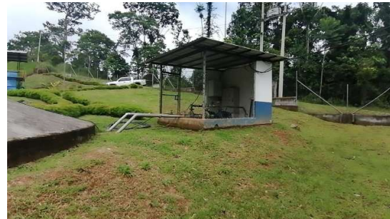
Reserva baja y estación de bombeo
