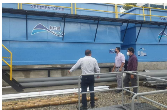
Sistema de Agua Potable para el Barrio Nuevo Coca-Francisco de Orellana- Municipalidad del Cantón
