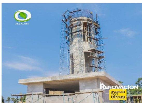
Sistema de agua potable comunidad Río Tiputini – Dayuma - Francisco de Orellana
