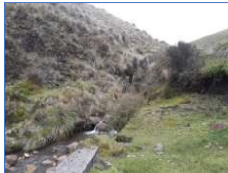
Imagen 3 Construcción Obras de Captación
