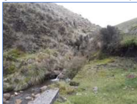
Imagen 3 Construcción Obras de Captación
