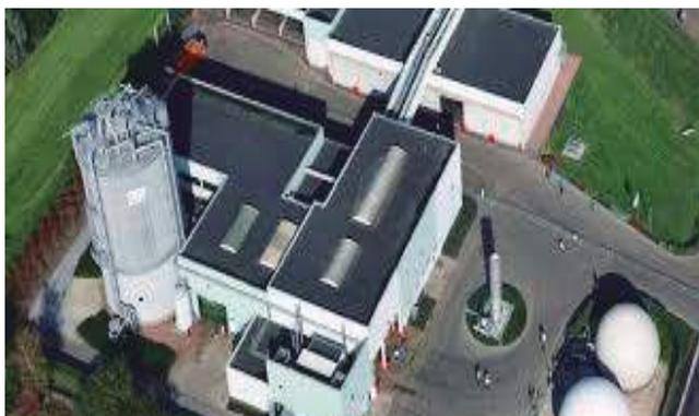
Los sistemas de metanización consisten en la degradación biológica anaerobia (sin oxígeno) de la materia orgánica. En el proceso se produce un gas combustible comúnmente denominado biogás, constituido mayoritariamente por metano y dióxido de carbono, con vestigios de gas sulfhídrico, N<sub>2</sub>, O<sub>2</sub>, H<sub>2</sub>, entre otros.
