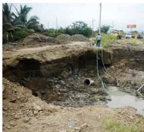
Sistema de alcantarillado destruido en la provincia de Manabí, zona de estudio 4. Fuente: MAE, 2016.
