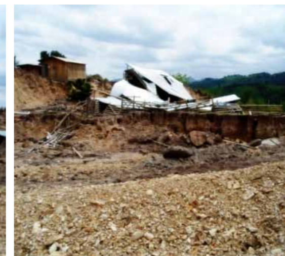
Hundimientos de grandes extensiones de terreno en la provincia de Manabí, zona de estudio 1. Fuente: MAE, 2016.
