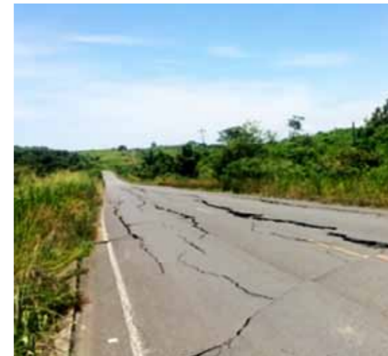
Alteraciones morfológicas del suelo y deslizamientos en la provincia de Manabí, zonas de estudio 1(izq.) y 3(der.). Fuente: MAE, 2016.
