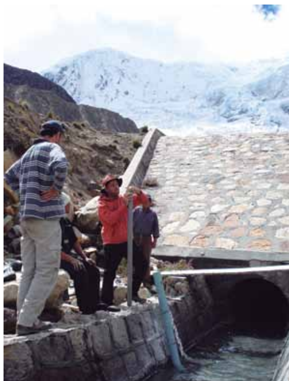
Medida del caudal en la salida de la laguna Palcacocha, en Cordillera Blanca. El dique morrenico natural de esta laguna ha sido reforzado a fin de canalizar los posibles desbordes. Foto M. Baraer
