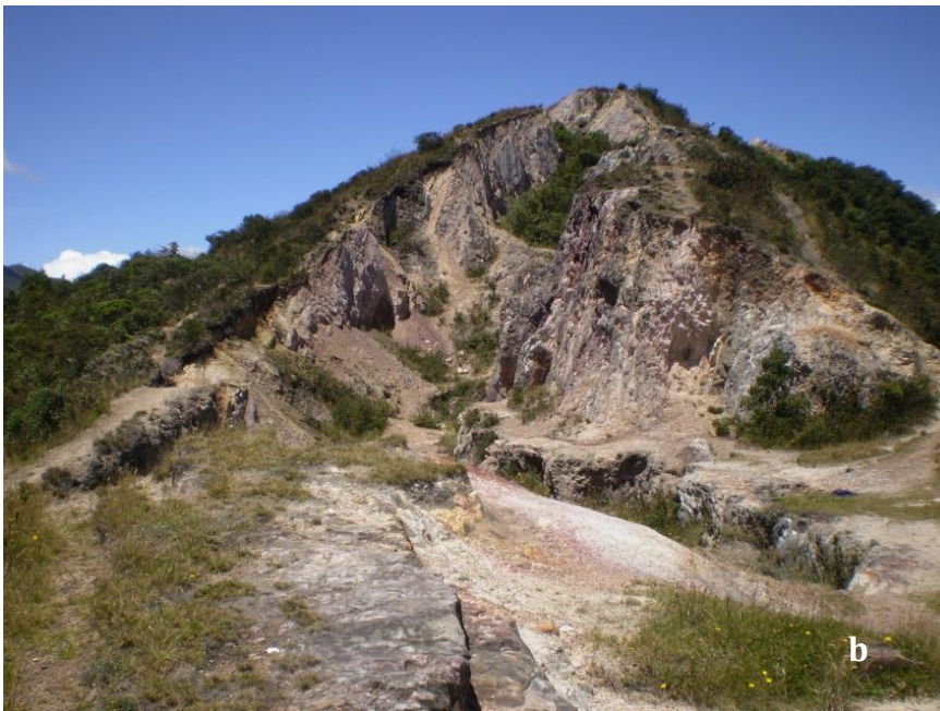
Figura 5. Diferentes ejemplos de acciones de restauración de acuerdo con las características del disturbio y las metas propuestas a. Laderas erosionadas dentro de la cuenca del Rio Jatuhuaico, las acciones realizadas con el fin de recuperar la cobertura vegetal y disminuir la erosión corresponderían a rehabilitación. b. Áreas afectadas por extracciones mineras en bosque altoandino, severamente degradadas donde se deben implementar acciones de remediación Fuente: Velasco-Linares 2013
