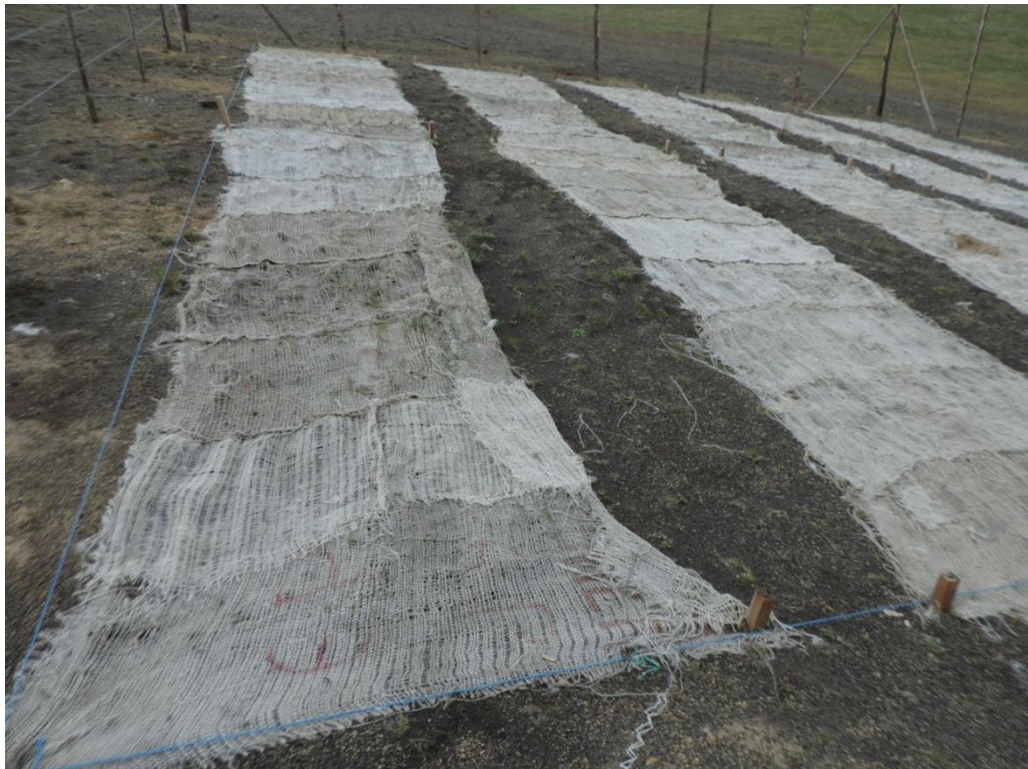
Figura 16. a y b. Instalación de biomantos a manera de un tapete o franja de yute. c Aspecto del crecimiento de la vegetación dentro de las franjas de yute, tres meses después de haber instalado el biomanto.
